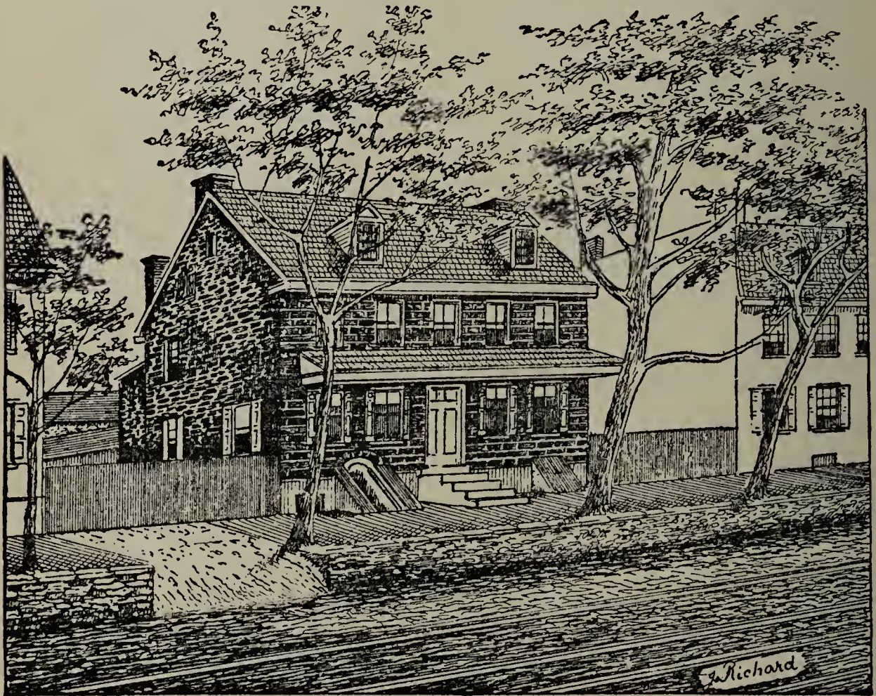
Wohnung von Dirck Keyser in Germantown, Pa., durch ihn selbst errichtet in 1691.
